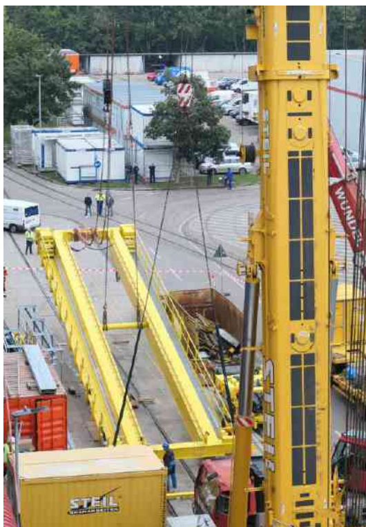
Einhub der neuen Kranbrücke
