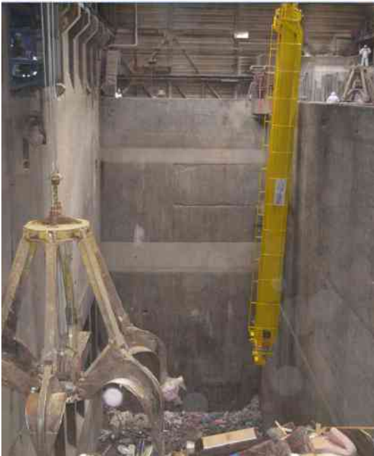
Einhub der neuen Kranbrücke
