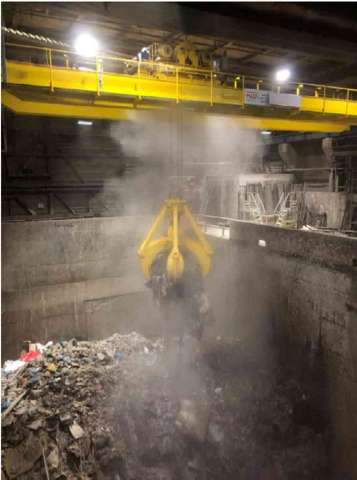
Erster Müll am neuen Müllkran
