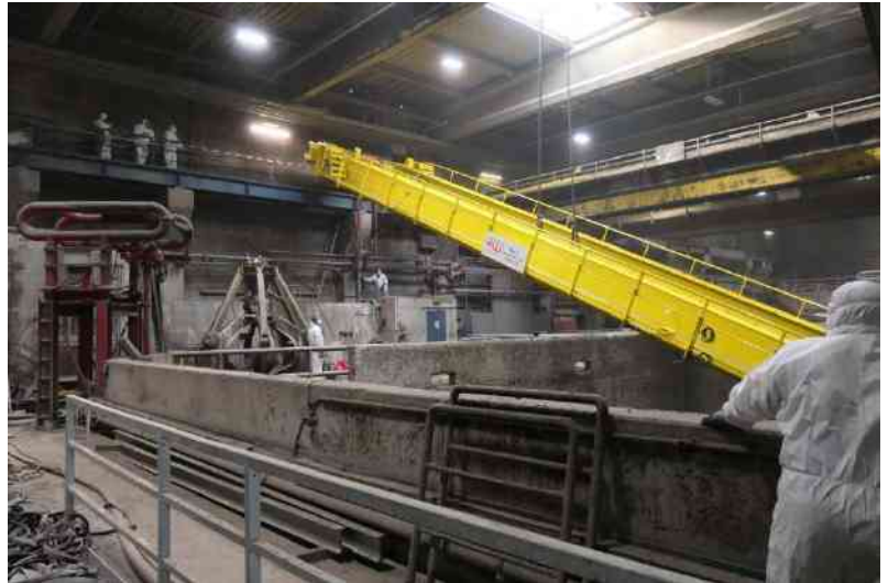
Drehen der neuen Kranbrücke im Müllbunker
