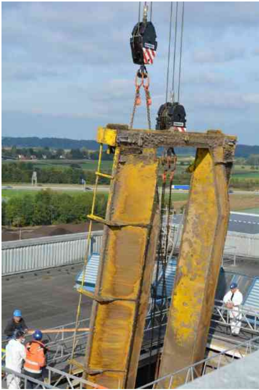
Aushub der alten Kranbrücke und der Laufkatze
